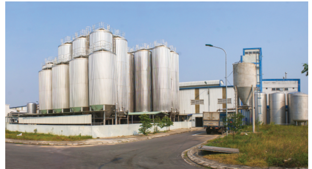
Nhà máy Bina Hà Nội tại khu công nghiệp Quán Ngang
