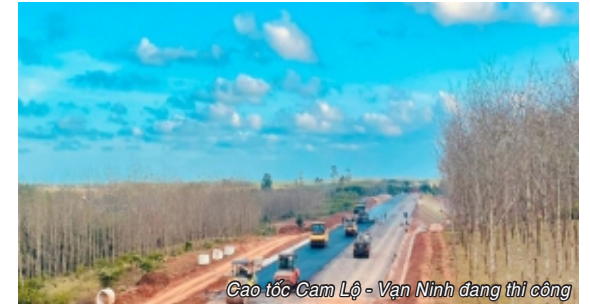
Cao tốc Cam Lộ - Vạn Ninh đang thi công
